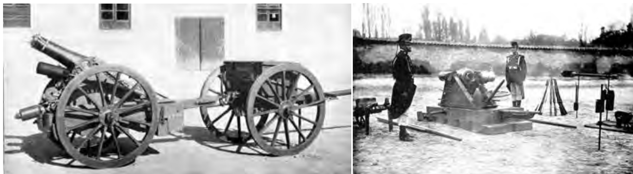
150-мм мортира Мата на колесном лафете (слева) и стационарном станке (справа)
