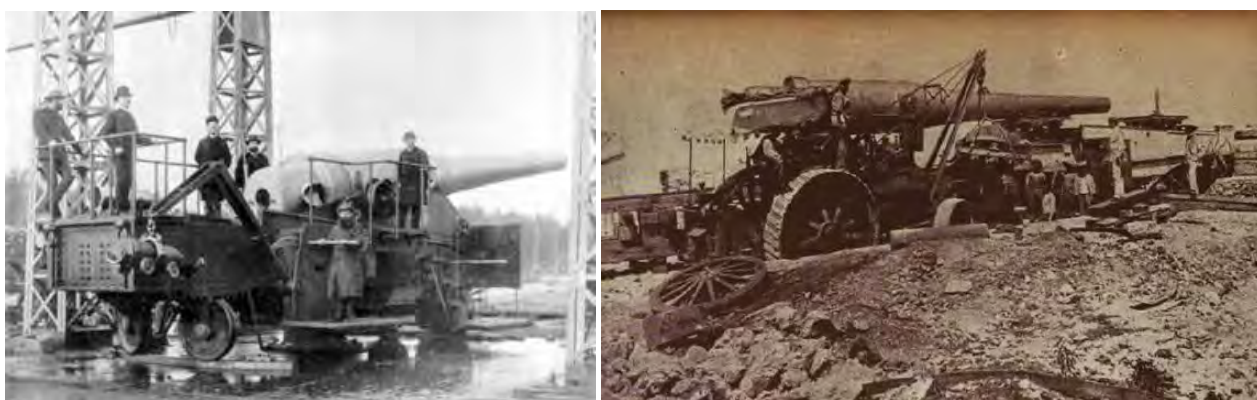
305-мм орудие Круппа образца 1887 г. справа – установка орудия на батарее № 2 Гаваны
