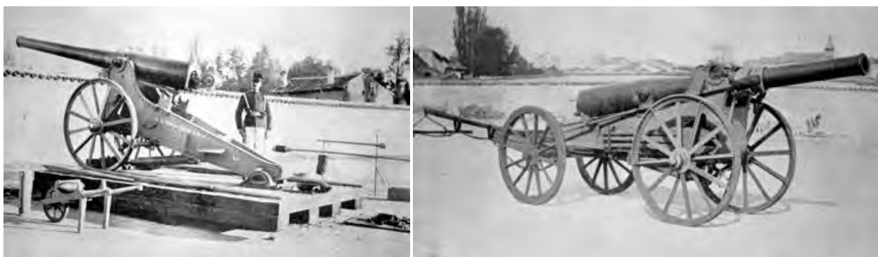
150-мм орудие Вердес образца 1891 г. в боевом и транспортном положении
