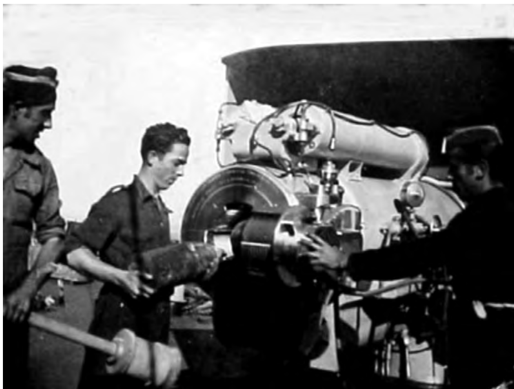
Рис. 9. Тренировка расчета 152-мм орудия. Человек в центре производит зарядание снаряда, слева – готов его досылать, человек справа – открывает затвор
