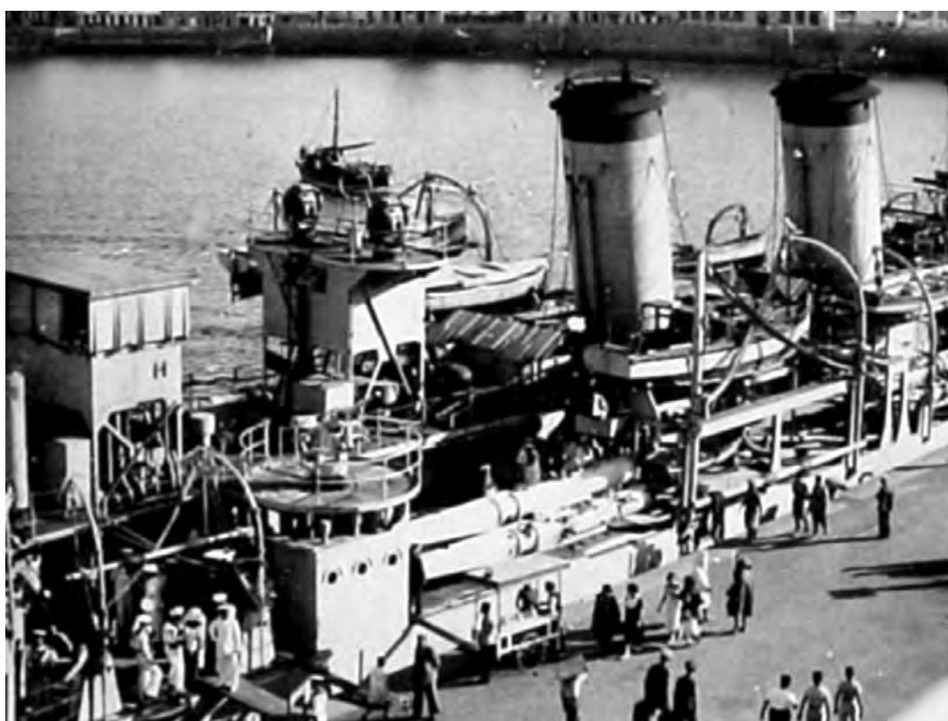
Рис. 10. Вид на центральную часть крейсера «Méndez Núñez». Хорошо видны прожекторные платформы и платформы с 47-мм зенитными пушками. Под ними – трехтрубный торпедный аппарат, центральная труба поднята над крайними
