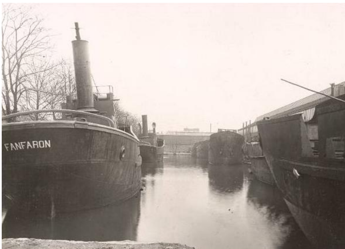
Рис. 11. Достраивающиеся на плаву тральщики
