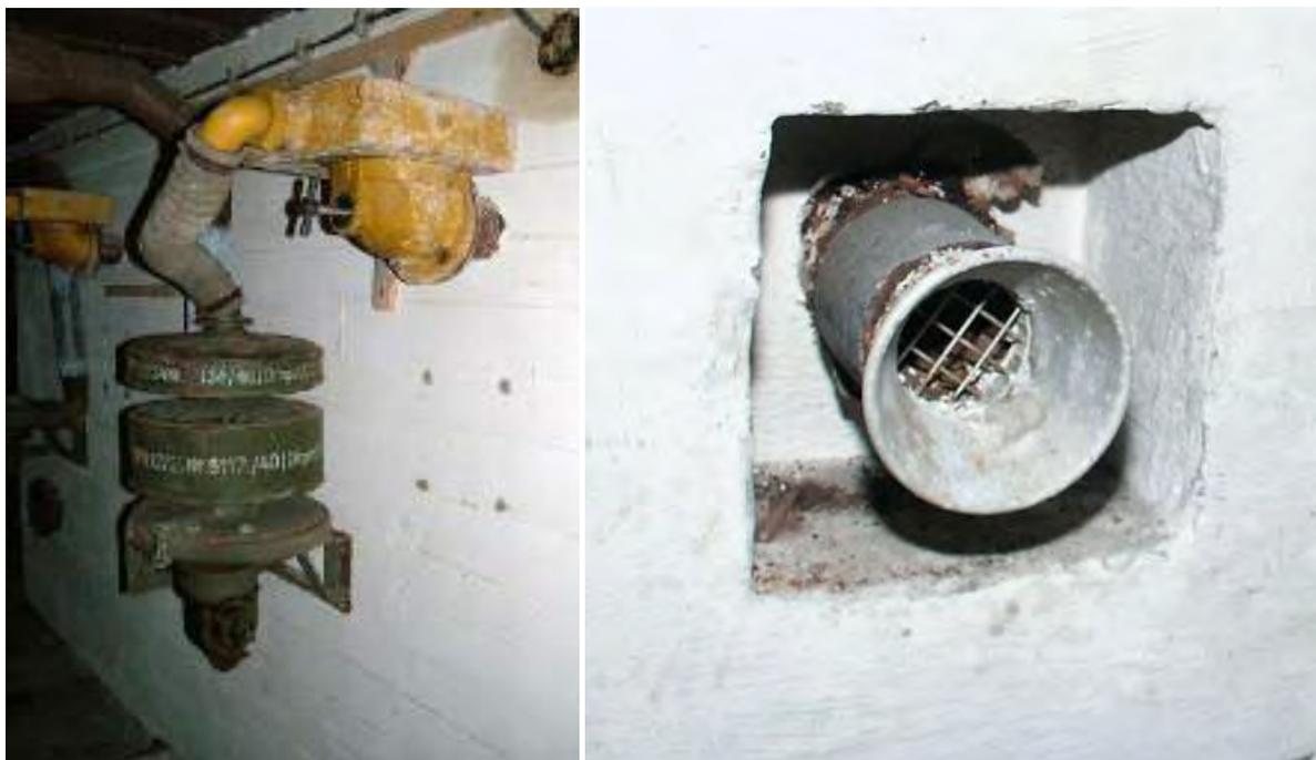
Оборудование немецких батарей: фильтро-вентиляционная установка
