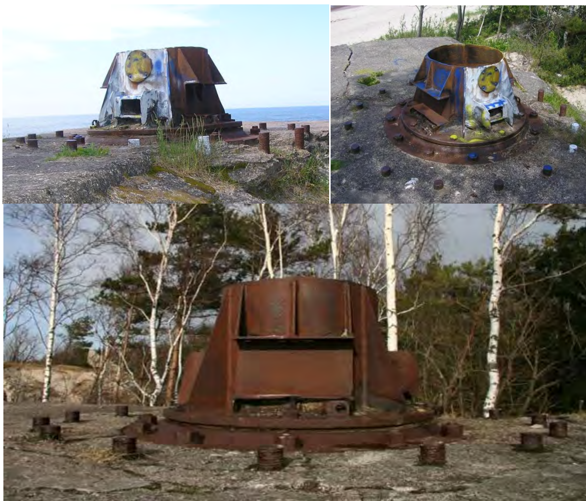
Бетонное основание для орудия, построенное взамен разрушенного с остатками лафета 12,8 cm Flak 40 M (фото Златы Раевской)
