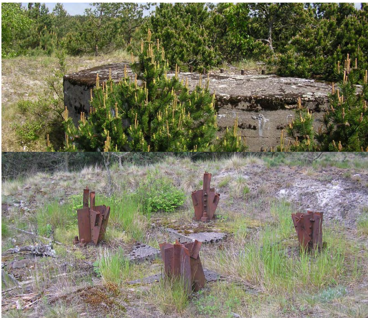
Развалины батареи "Memel-Süd" (фото Златы Раевской): бетонное основание орудия с крепежными болтами (вверху), остатки дальномерной вышки (внизу)
