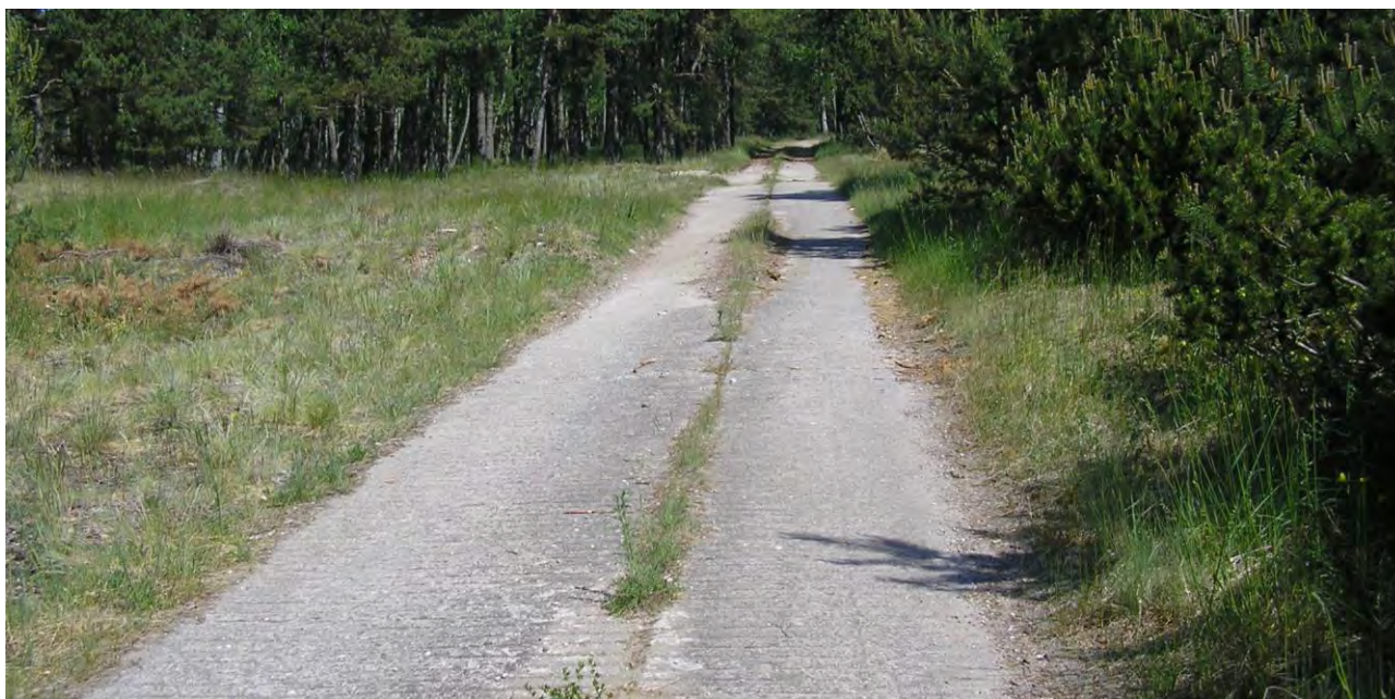
Бетонная дорога к батарее "Schweinsgrücken" (фото Златы Раевской)
