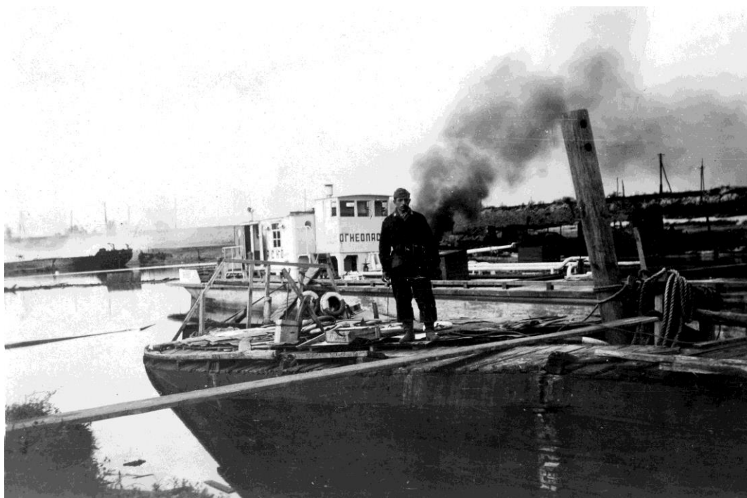
Рис. 2. БН-160 (баржа нефтеналивная) на службе в Вермахте, Днепр
