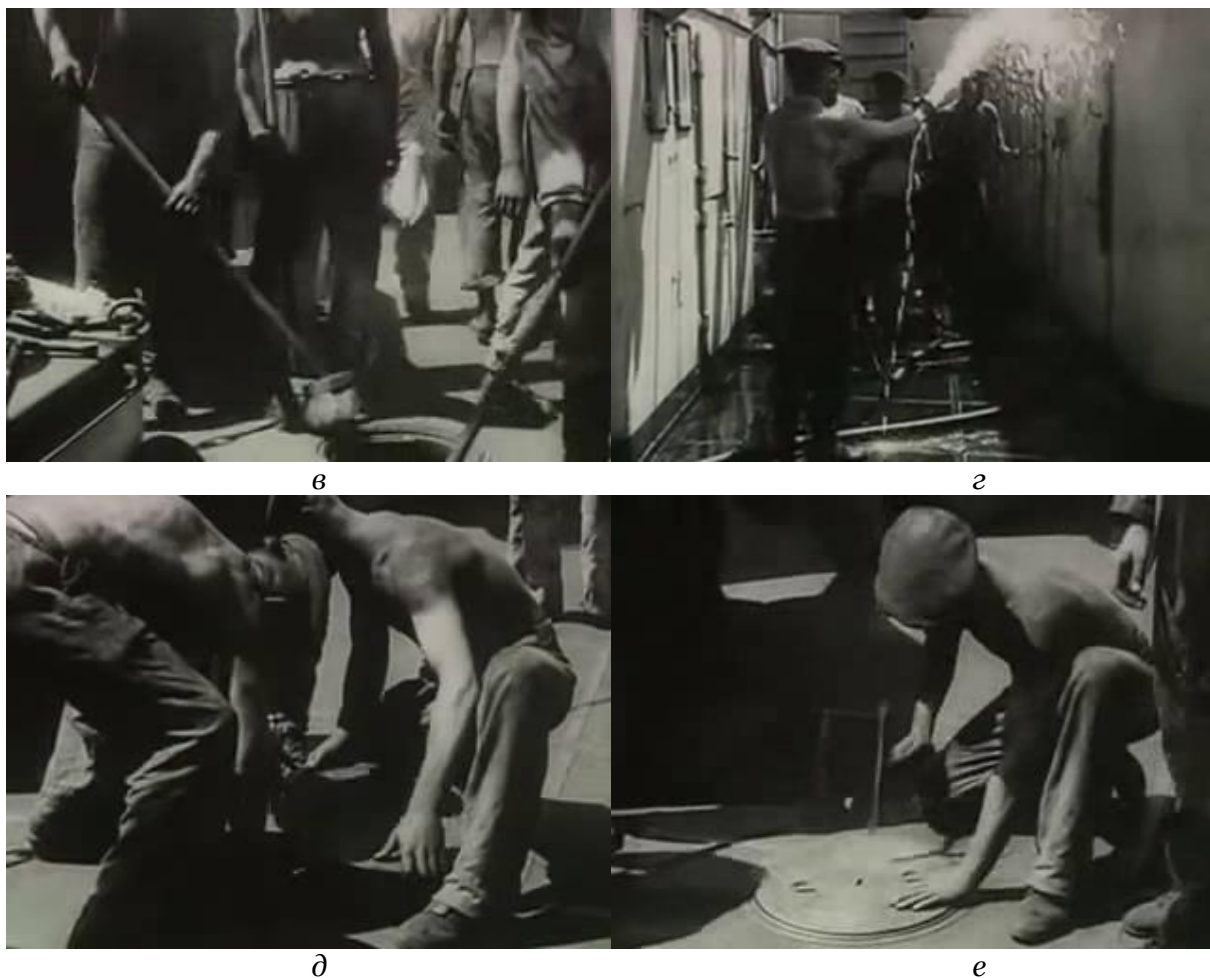
Рис. 6. Кадры из фильма «Крейсер “Эмден”»: а – кучи угля на причале, матросы загружают его в тачки; б – судовой ансамбль пытается оживить бункеровку; в – очистка горловины бункера; г – промывка корабля (переборок, палубы, бортов и т.д.); д – затворение горловины бункера; е – завинчивание горловины (Ральф, 1932)
